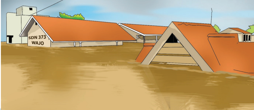
Kondisi Sekolah Setelah Banjir.
